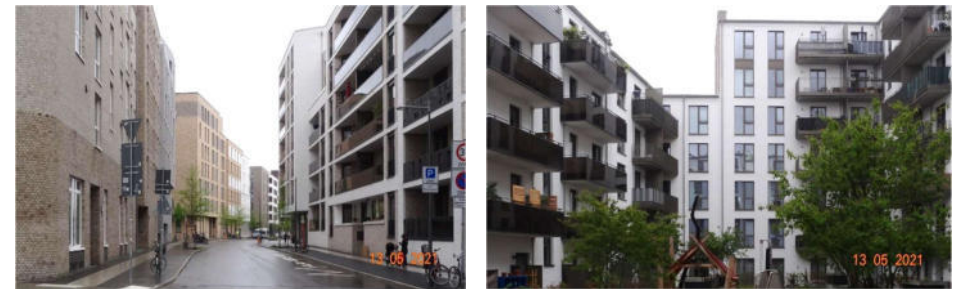
Abb. 1 + 2: Beispiel Neue Mitte Altona: Düstere Straßenschluchten und enge Blockinnenhöfe – GFZ 3,23 - 4,92
